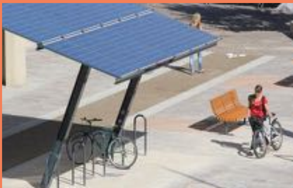
borne de recharge solaire pour vélos
